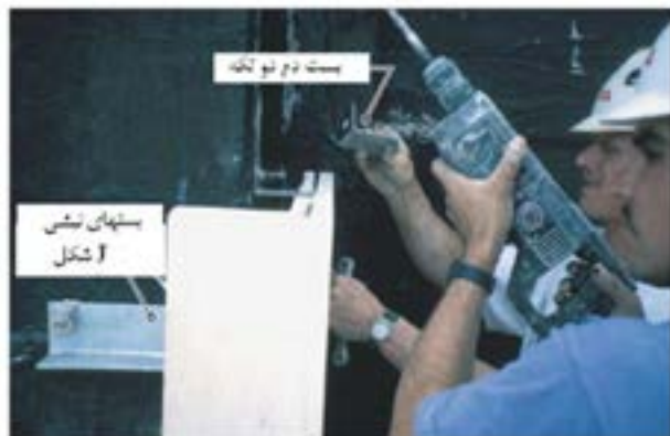
شکل ۱۰ - بست‌های دم دوتکه که به صورت مستقیم به دیوار پشتیبان متصل شده‌اند
