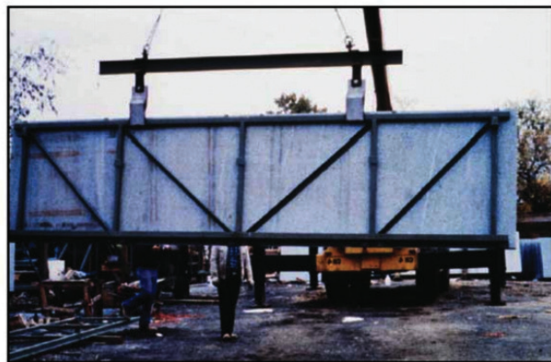
شکل 4- پانل دیواری پرده ای پیش ساخته سنگی
