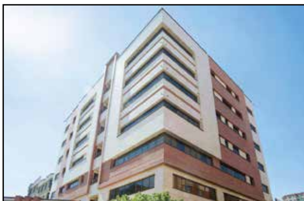
اجرا شده توسط شرکت آلوکد
