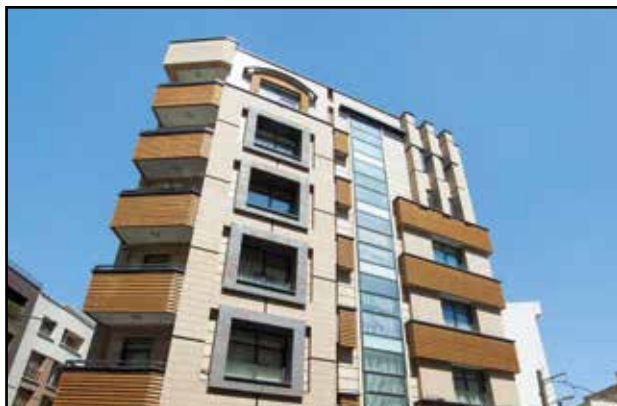
اجرا شده توسط شرکت آلوکد
