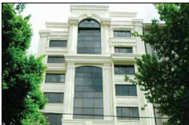
اجرا شده توسط شرکت آلوکد
