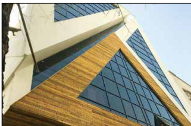
اجرا شده توسط شرکت آلوکد
