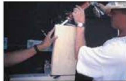
شکل ۱۲ - پر کردن شیار موجود در قطعات سنگی قبل از نصب بست‌ها
