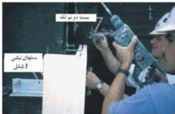
شکل ۱۰ - بست‌های دم دوتکه که به صورت مستقیم به دیوار پشتیبان متصل شده‌اند
